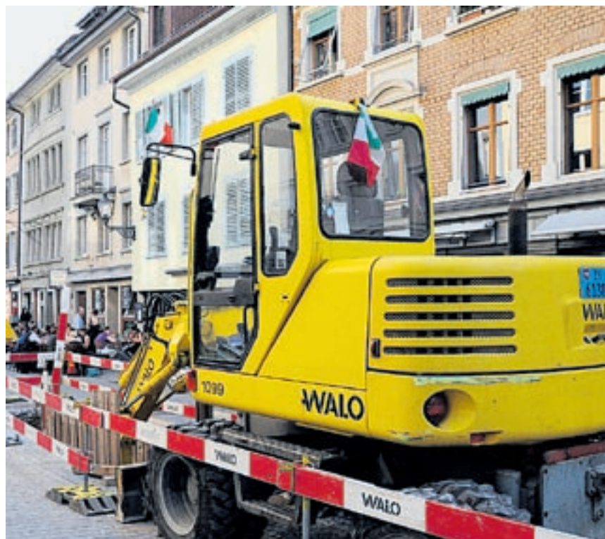
Dieser Bagger hat bis vorgestern den Boden der Metzggasse aufgerissen und ist ohne Partikelfilter unterwegs, was die Stadt verboten hat. Bild: Stefan Schaufelberger
